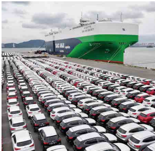
厦门东渡港区现代码头。新华社记者 姜克红 摄
